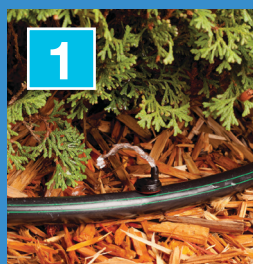
Emisor de goteo insertado en un tubo simple
